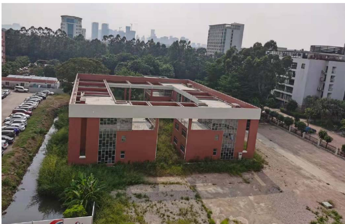
3号实验楼现状照片
